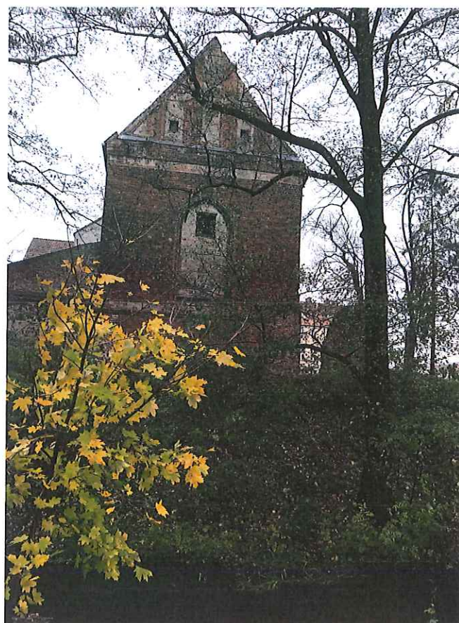
Fot. 4. Wschodnia ściana kościoła prezbiterium
