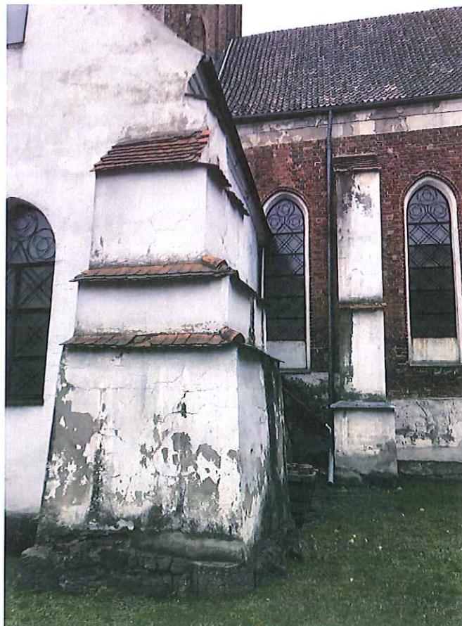
Fot. 9. Południowa ściana prezbiterium kościoła i kaplica
