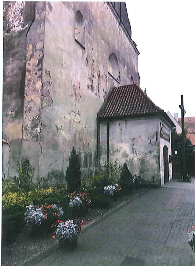
Fot. 1. Wejście do kościoła - zachodnia ściana nawy
