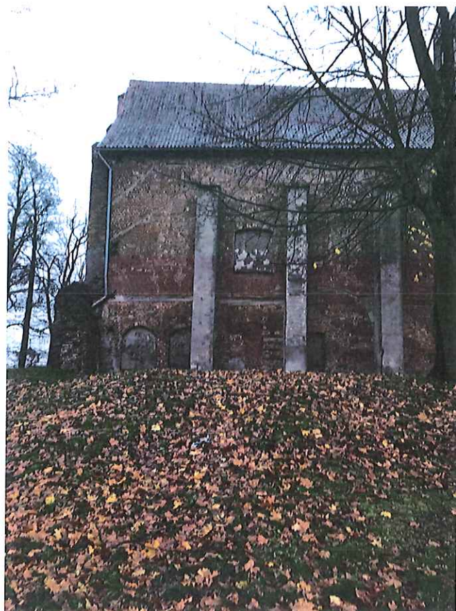
Fot. 8. Północna ściana prezbiterium kościoła
