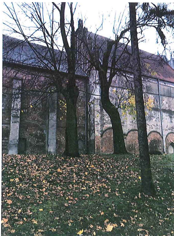
Fot. 7. Północna ściana prezbiterium i nawy kościoła
